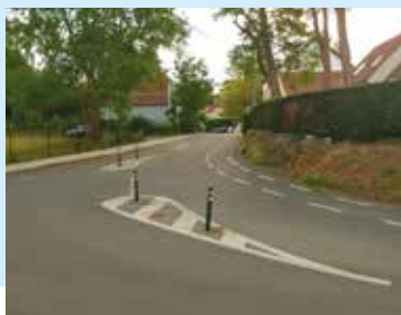
• Aménagements des voiries
