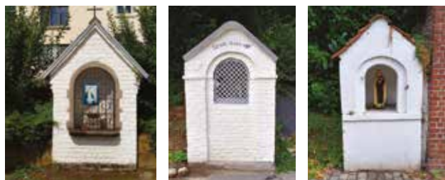
• Réfection de potales et chapelles
