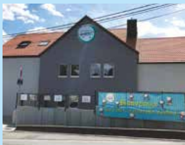
• École de Rosières
